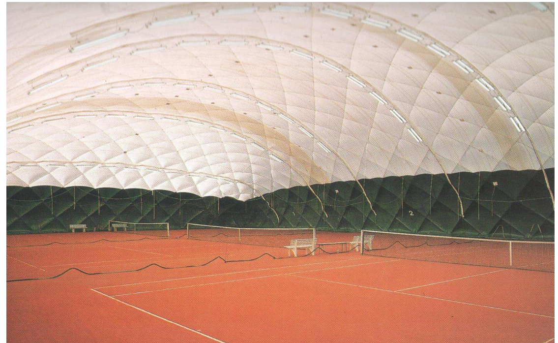
4-Feld Traglufthalle über den Plätze 1-4
