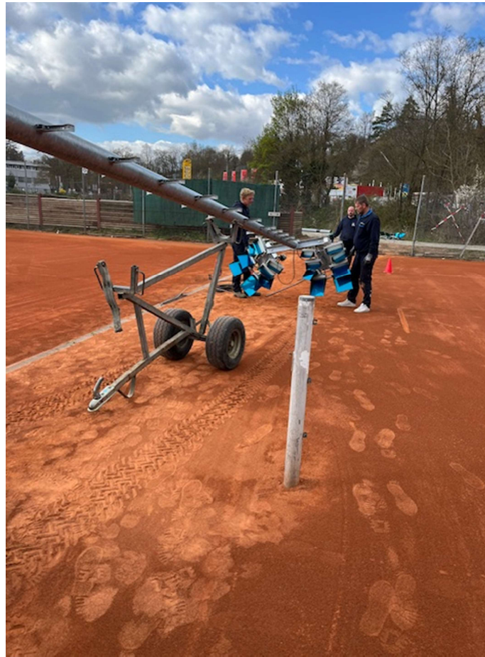
Flutlichtmasten einbringen
