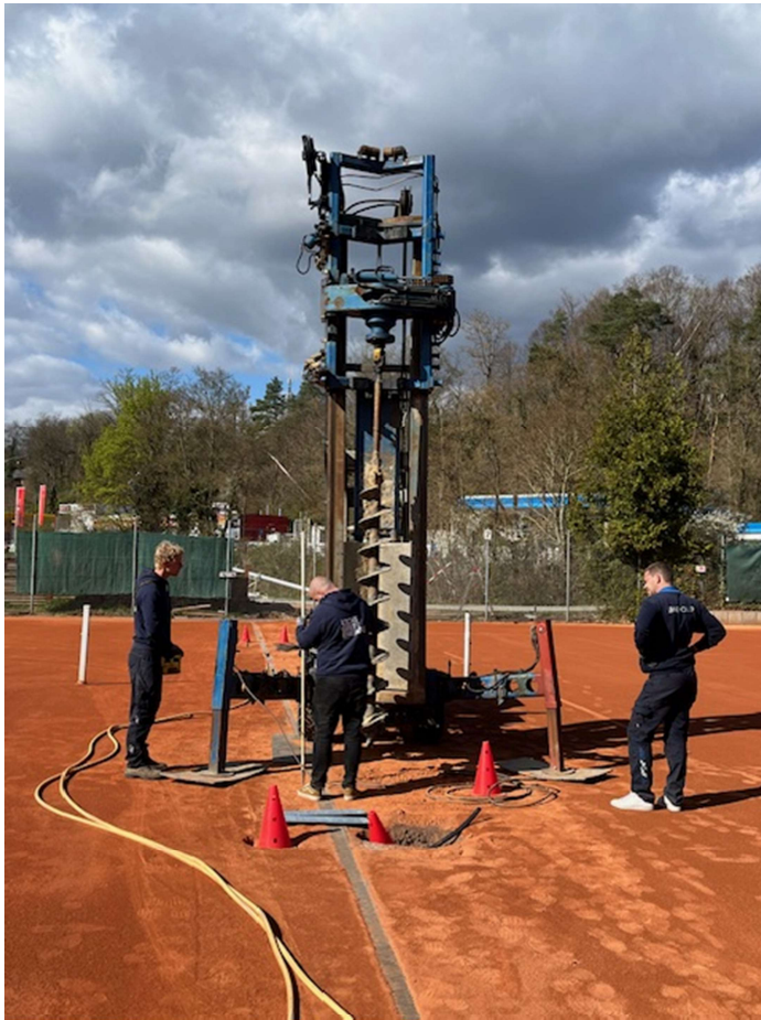
Erdb Bohrungen für Masten
