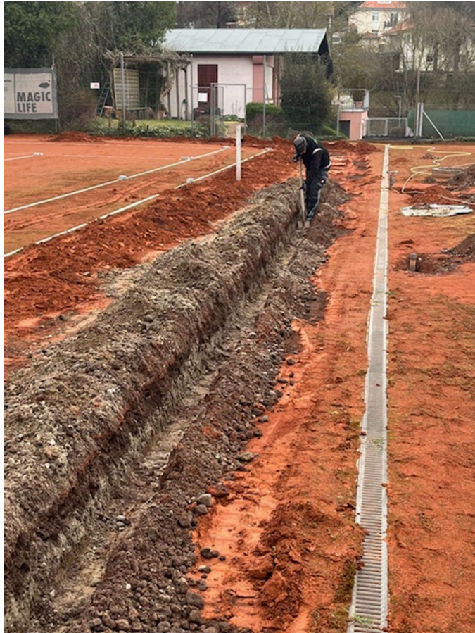
Graben für Stromkabel auf Platz 7
